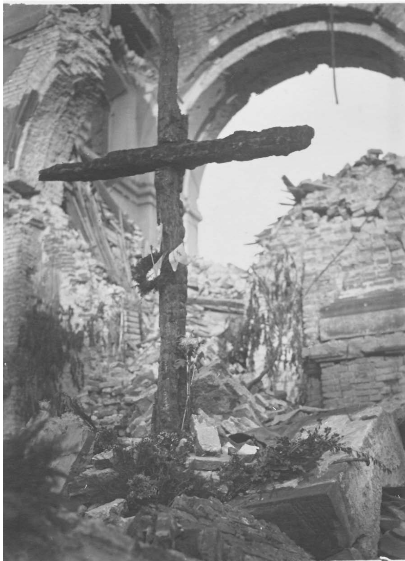
1. Krzyż ustawiony na ruinach kościoła sióstr sakramentek w Warszawie.
